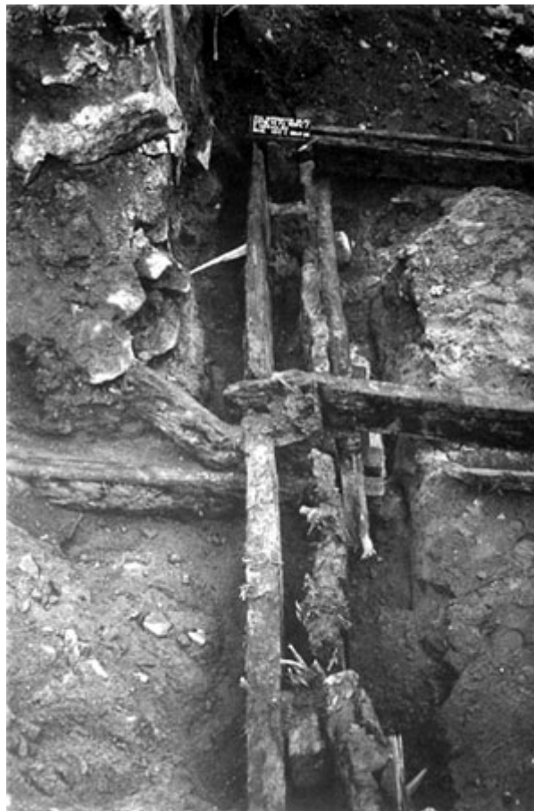
Figura 6. Detalle del cimiento hidráulico.
