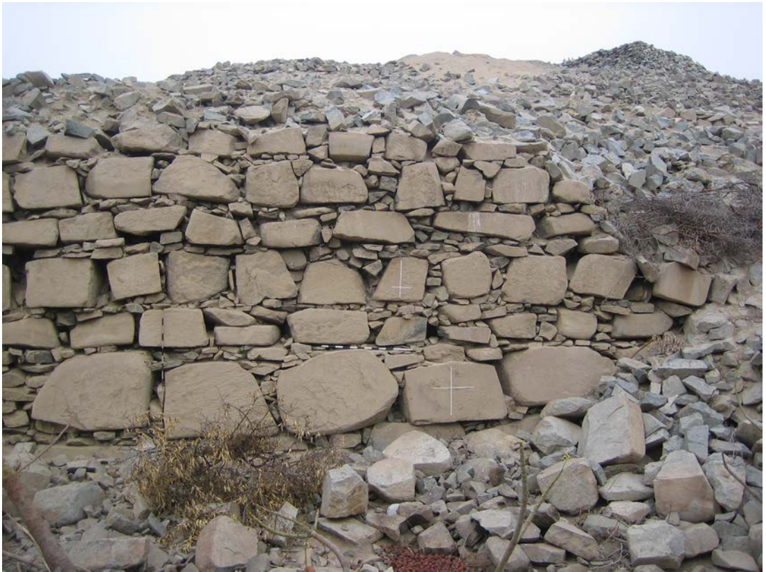
Figura 18. Vista de paramentos del sitio de Sechín Alto. View of veneers from the Sechín Alto site.
