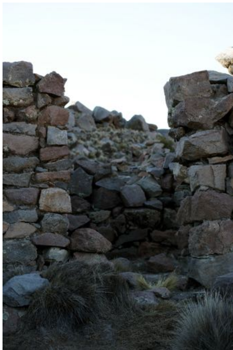
Figura 10. Espacio de ingreso al recinto 69, presenta jambas en mampostería mixta, sector 4, sitio Pueblo Viejo de Parinacota.
